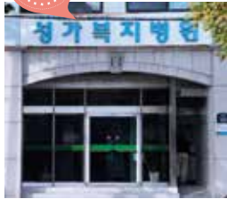
성가복지병원 스프링클러 설치 & 내부 재단장 공사
